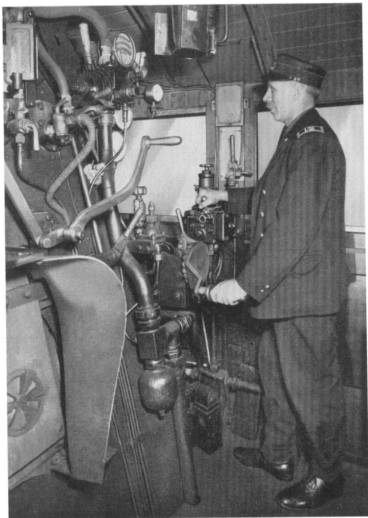
Fig. 48 Automatisk Førrerventil, Konstruktion Knorr, i Førrerhuset paa et dansk Lokomotiv
