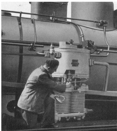
Fig. 18a Udbygning af P-Styrings Hovedstyreglider
